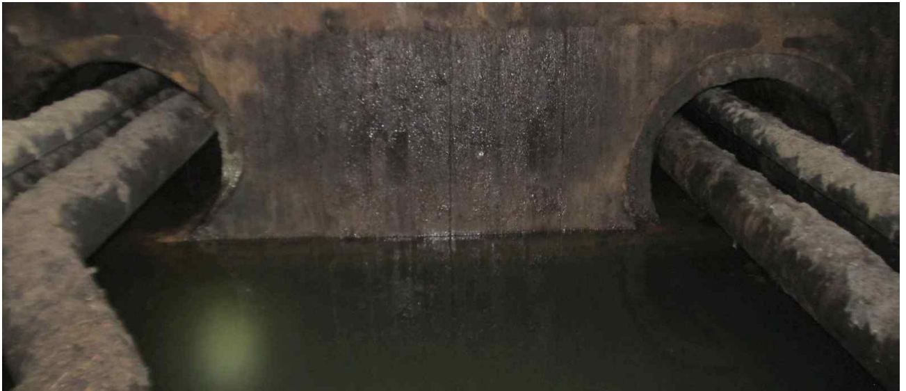
Původní potrubí v chráničkách DN800
